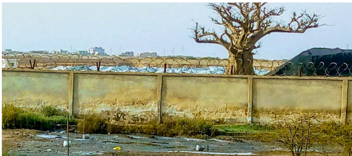
Photo 7 - Les rejets d'eaux usées sur le terrain de Khelcom et les tas de cendres stockés à même le sol
