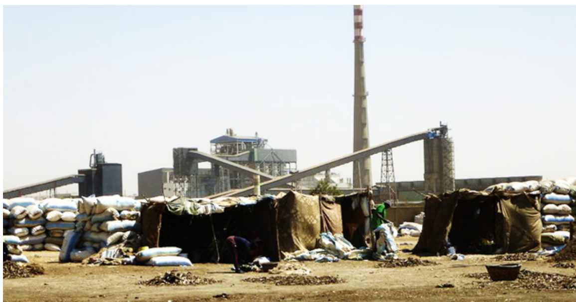
Photo 20 - abris de femmes de khelcom en contiguïté avec la centrale à charbon.png
