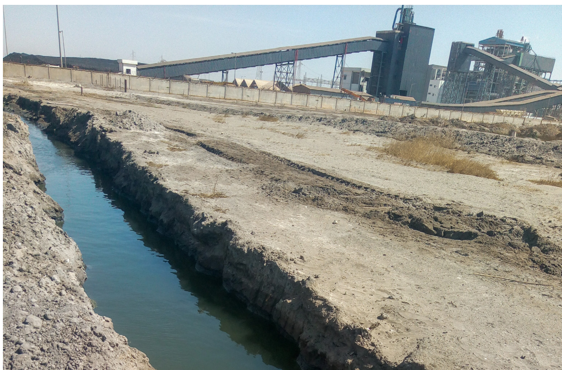
Photo 4 - Canal à ciel ouvert servant d'évacuation des eaux de la centrale à charbon
